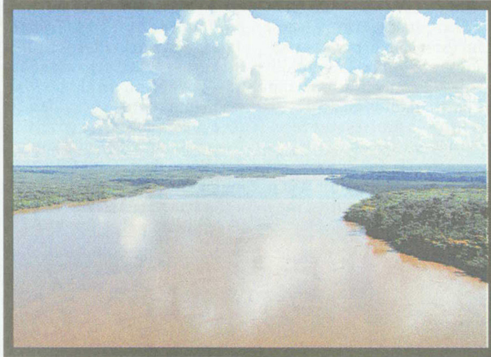
RIO MADEIRA: PROJETO DA HIDRELÉTRICA DE JIRAU FOI APROVADO PELA ANEEL
