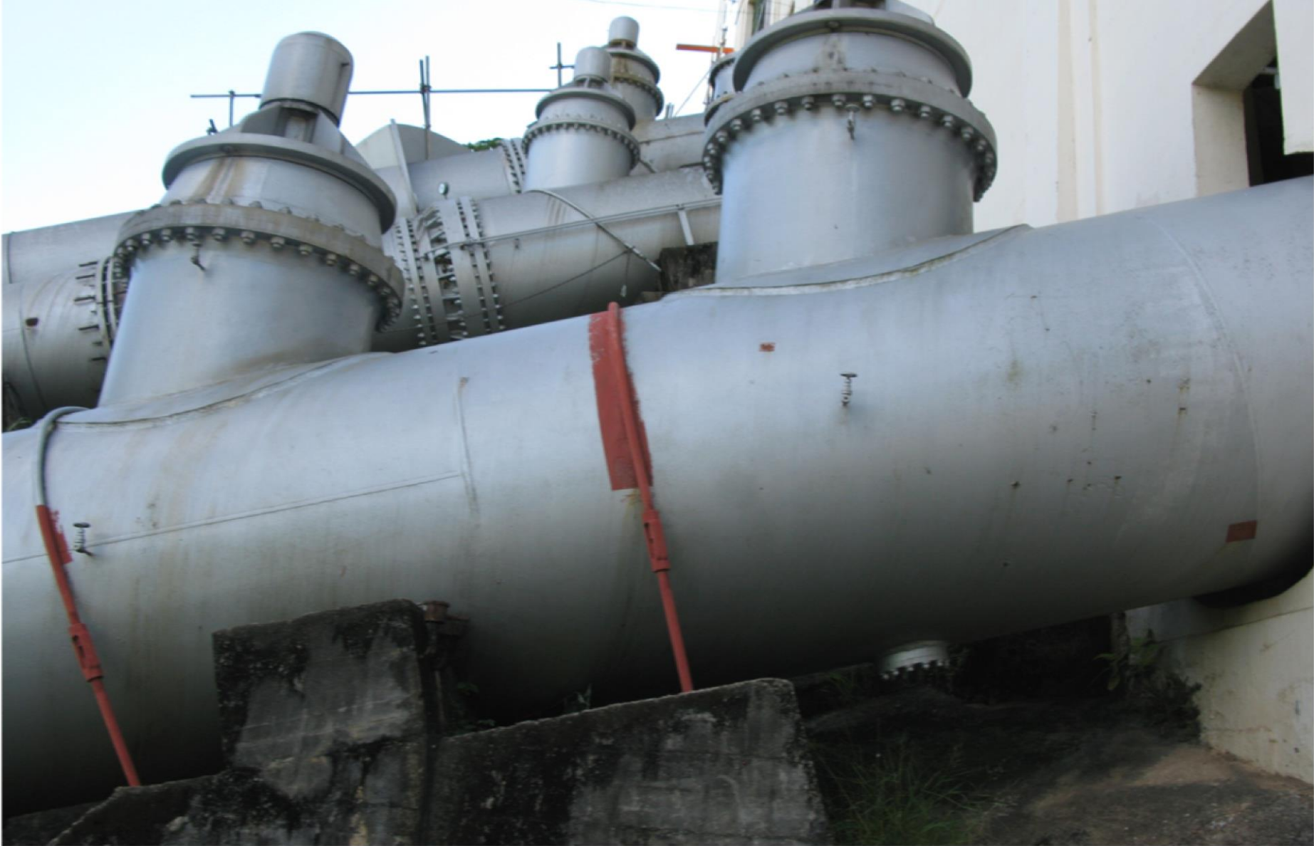
Casa de Válvulas
