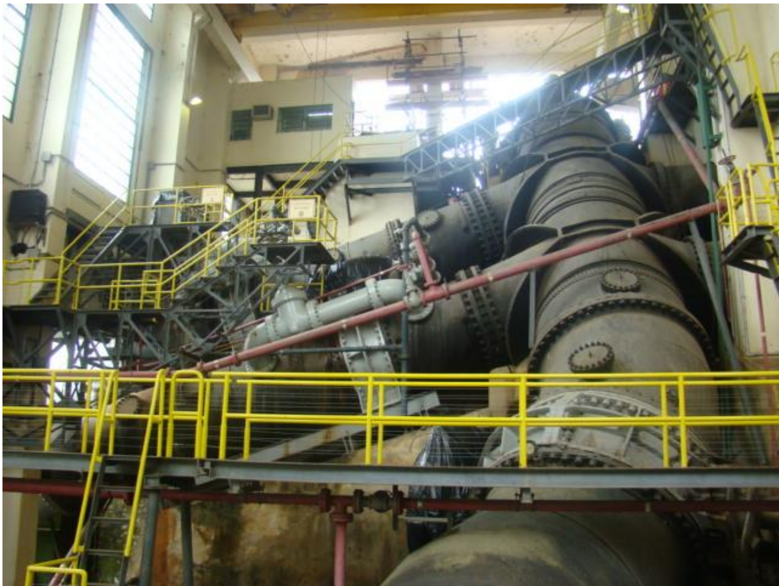
CASA DE VÁLVULAS
