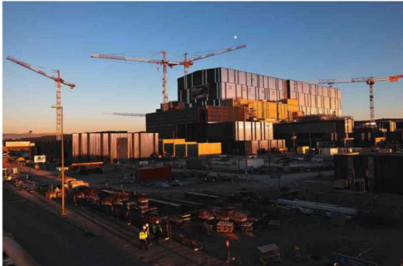
Canteiro de obras do Iter Tokamak, máquina experimental de fusão nuclear, na França. Cao Jing - T' dez.23/Xinhua
