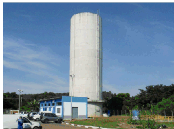
Fig. 5. Vista da Chaminé de Equilíbrio (CEQ) de 11,0m de diâmetro e 35,1m de altura
