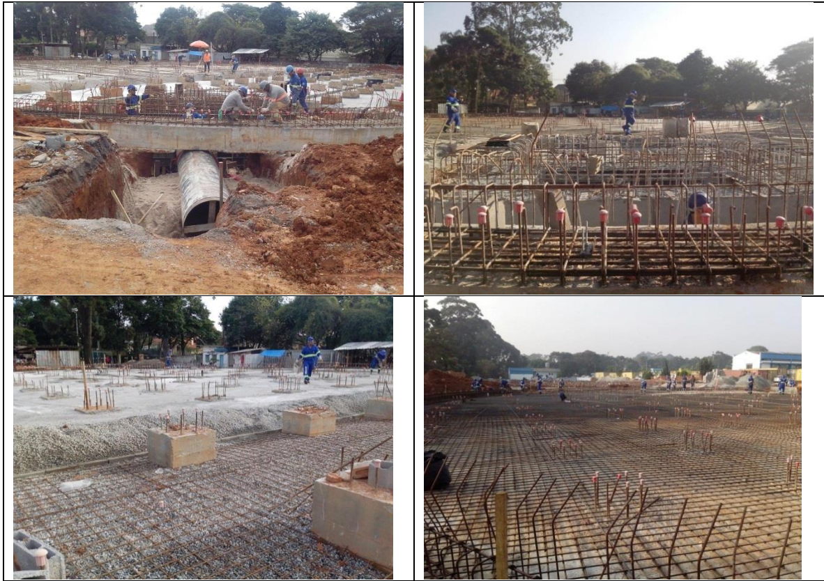
Obras da fundação para os novos Reservatórios ETA RJCS
