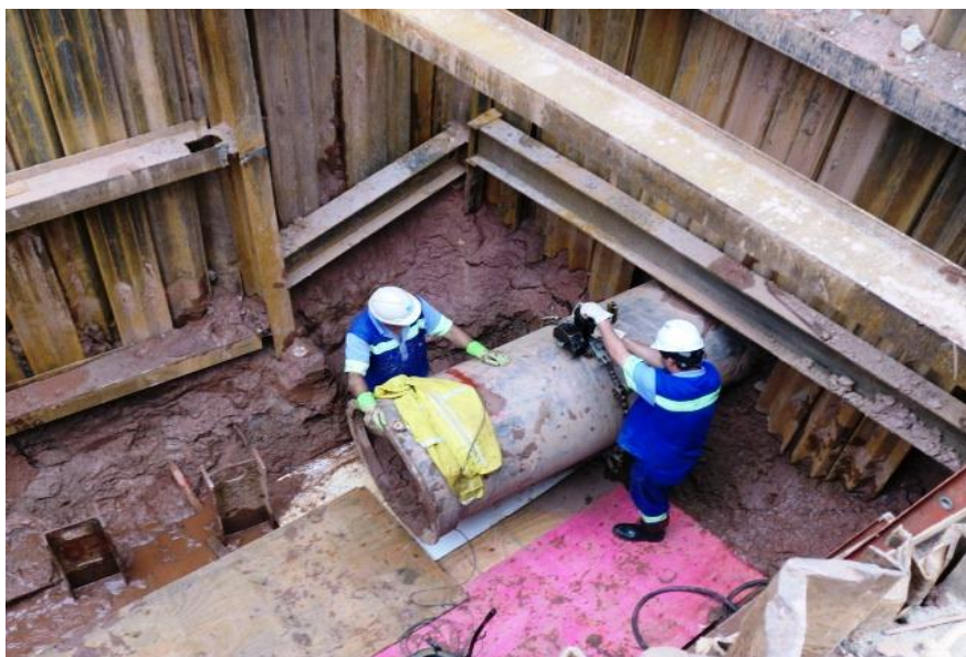
Derivação do Horto - Substituição de válvula de 600 mm
