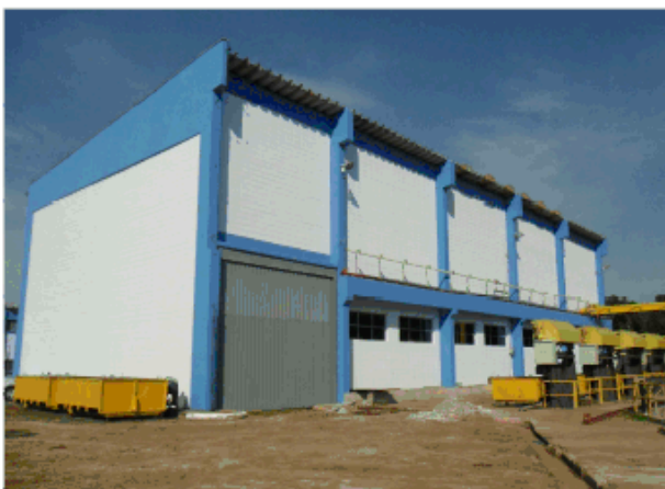
Fig. 4. Vista externa da casa de bombas
